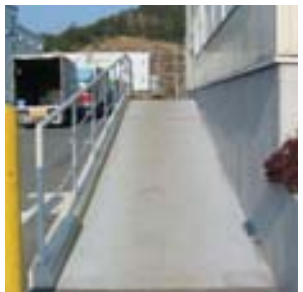
スロープのついたエントランス
