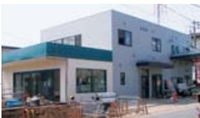
埼玉県新座市にあるヤマト運輸の土地を借りて建設が進む
