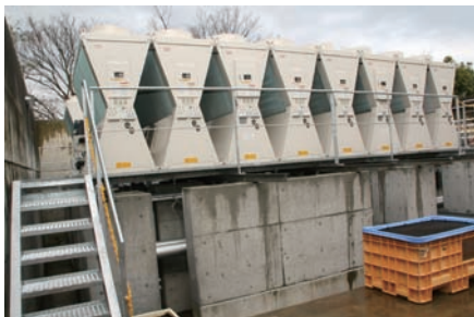
津波被害を避け、高い位置に設置された熱源装置
