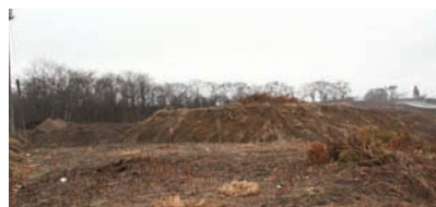
東西しらかわ農業協同組合 「地域農業再生基幹施設緊急整備事業」
