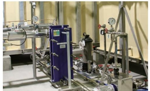
海水冷却装置と断熱貯水タンク 汲み上げた海水を濾過・冷却・殺菌し、配管を通じて市場内に供給
