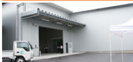
●東部共同農業倉庫 低温農業倉庫／鉄骨平屋 建て／建物943㎡、敷地 1,309.50㎡
