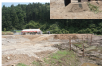
土地をかさ上げた建設予定地
