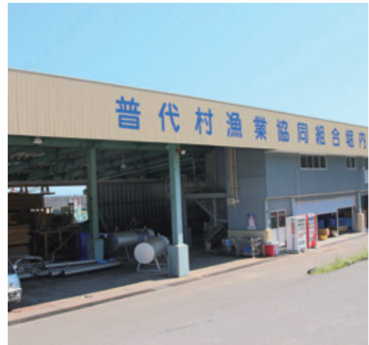
修復した堀内水産物荷捌施設
