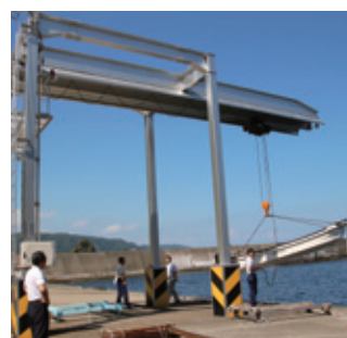
●黒崎漁港 船をつり上げるホイストクレーン
