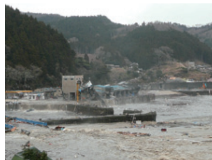
港にあった製氷・荷捌き施設は壊滅状態に
