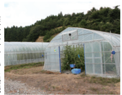
助成をもとに建てたビニールハウス
