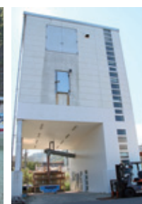
●太田名部漁港 修繕が完了し稼働し始めた製氷施設
