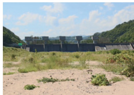
村を救った巨大な防潮堤と水門
