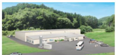
●鉄骨造、完全人工光型(完全閉鎖型) ●建築面積:2,467.10㎡/敷地面積:5,009.10㎡ ●栽培面積:4,324.8㎡(9.01㎡×8段15ライン×4室)
