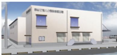
●鉄筋コンクリート造り(一部鉄骨造り、一部2階建て) ●延床面積: 1,516.27㎡ ●製氷能力: 71.8t/日 ●貯氷能力: 317t
