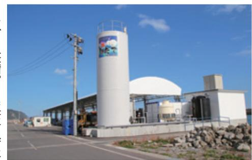
スラリアイス製氷能力18.5t/日、ドライアイス製氷能力5t/日、貯氷能力30tとなる新施設
