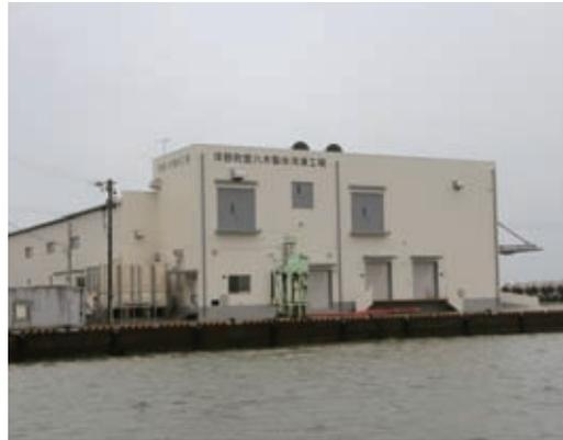
新施設は津波対策として機械室を2階に設置、環境負荷の低減を目的に自然冷媒を採用している
