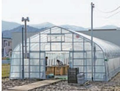
新たに建てた育苗ハウスは雪の重みにも耐えられる仕様。室温が12℃を下回るとボイラーが自動運転する仕組みも。上水道を散水する設備や遮光カーテンも備えた
