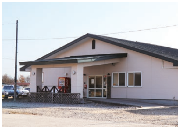
2004年に開設した(社福)ホープの事業所「フロンティア」。他にも2事業所、四つのグループホームも運営
