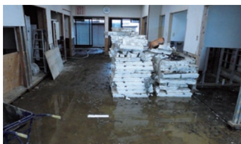
被災した建物内の様子
