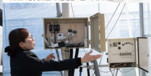
土壌センサーの情報を元に、水・液肥を自動調整、温度管理も自動で行い、データは県の農業技術センターにも送信されています
