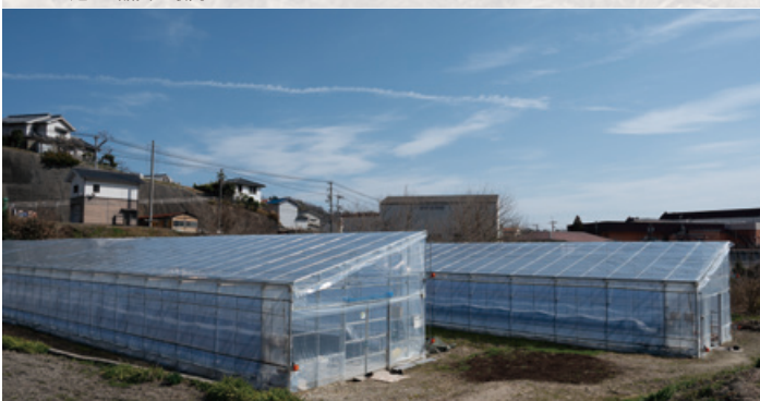
助成を活用して完成した片屋根型ハウス2棟。温度制御が可能な片屋根式の普及を進めていた香川県農研機構に協力を仰ぎ、無償で設計図面を作成していただいたという
