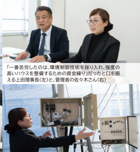
土壌センサーの情報を元に、水・液肥を自動調整、温度管理も自動で行い、データは県の農業技術センターにも送信されています
