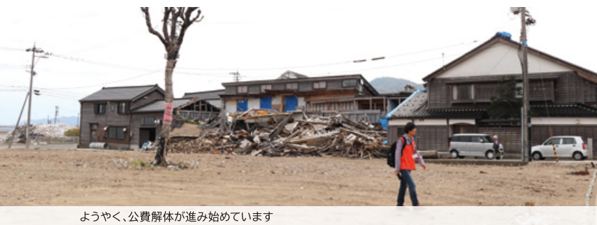
ようやく、公費解体が進み始めています
