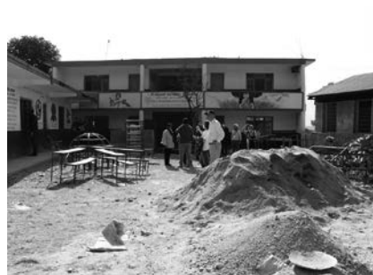
地震のために壊れた校舎の復旧 (ジーバン小学校)
