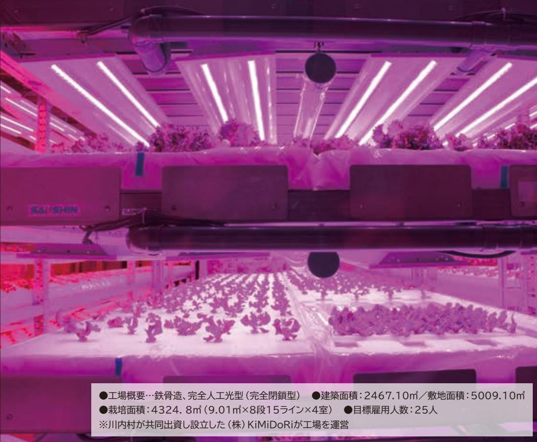
●工場概要…鉄骨造、完全人工光型(完全閉鎖型) ●建築面積:2467.10㎡/敷地面積:5009.10㎡
